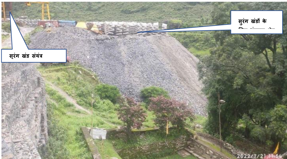
फोटो 2- कंक्रीट कास्टिंग प्लांट को समायोजित करने के लिए प्लेटफॉर्म
