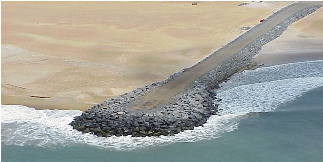
Photo 3. Exemple d'un épi empêchant l'érosion côtière (pas au Togo)
