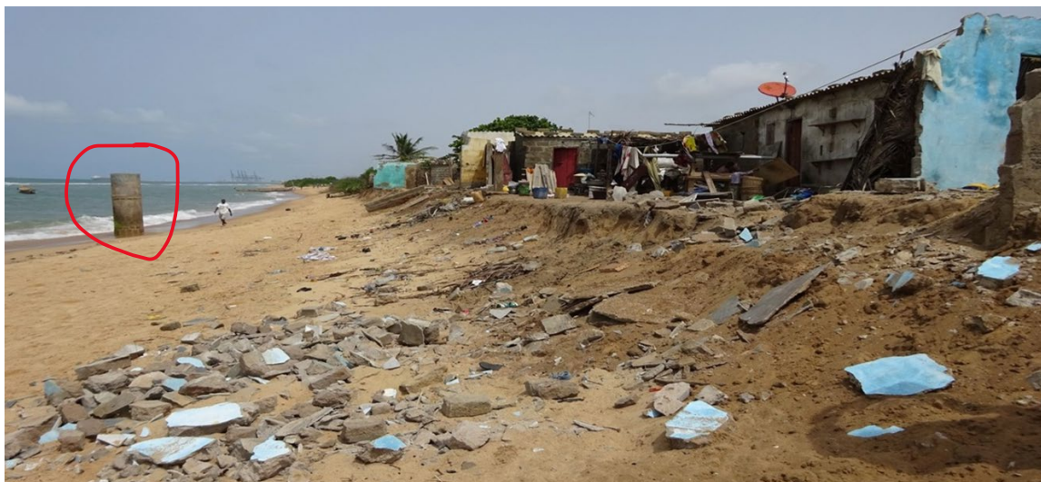
Photo 1. Erosion côtière au Togo; la structure à l'extrême gauche de la photo était un puits d'eau
