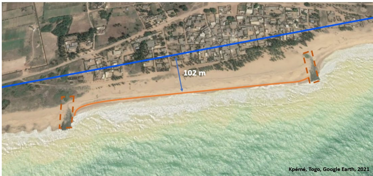
Photo 7. Gain des zones sableuses grâce à la construction d'épis
