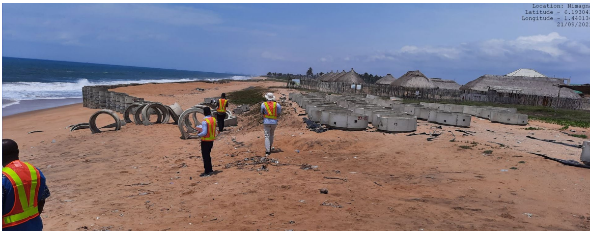
Photo 6. Ouvrages de protection d'urgence du littoral pour la protection des biens liés aux moyens de subsistance (un petit centre de villégiature) sont pratiquement achevés. Le surplus de matériaux de construction sera enlevé (21 septembre, 2021)
