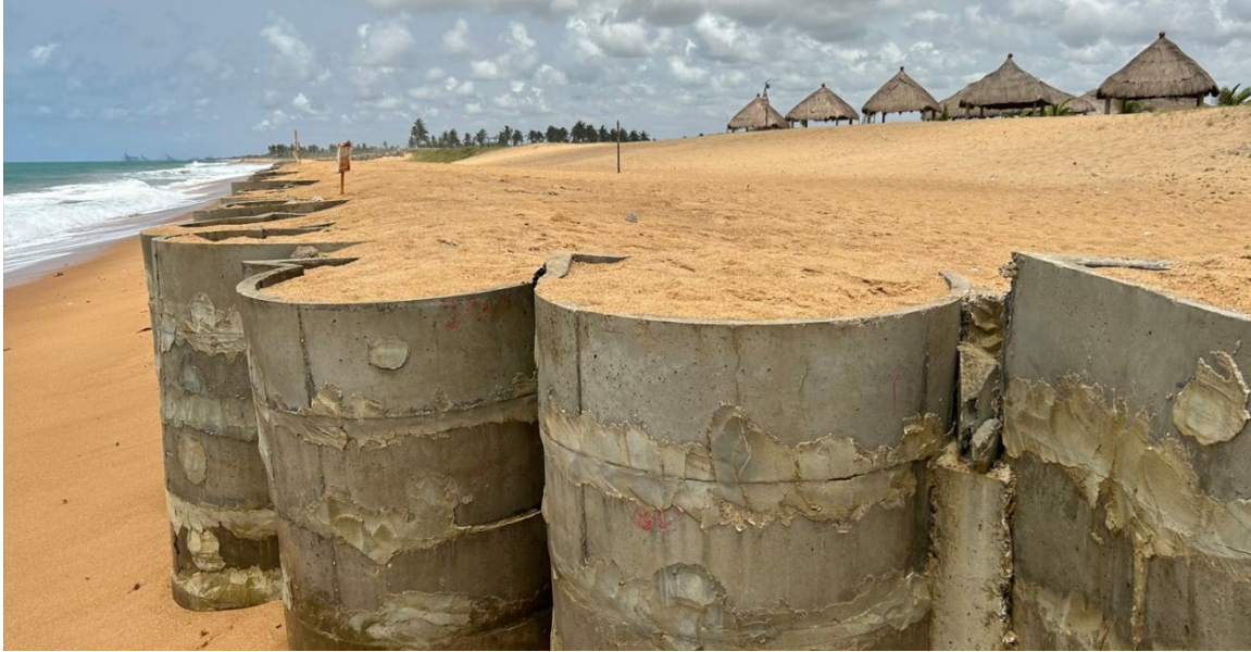
Photo 6. Achèvement des ouvrages de protection d'urgence du littoral pour la protection des habitations et des moyens de subsistance (mars 2023)
