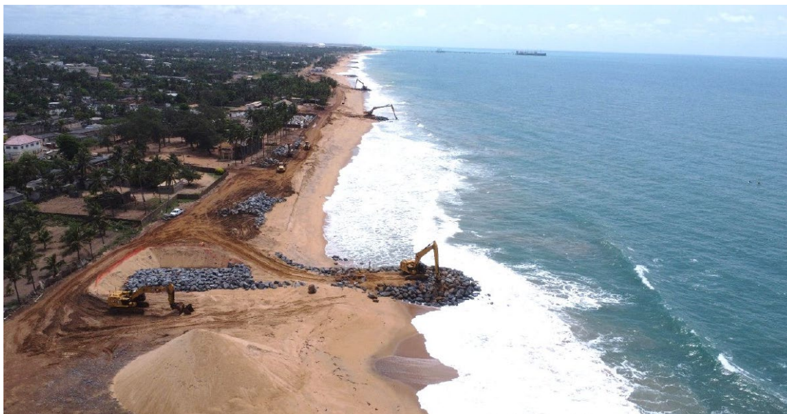
Photo 3. Exemple d'épis en cours de construction pour lutter contre l'érosion (mars 2023). Une fois la construction des épis achevée (prévue en juin 2023), la zone située entre les épis sera rechargée en sable (Agbodrafo, Togo).
