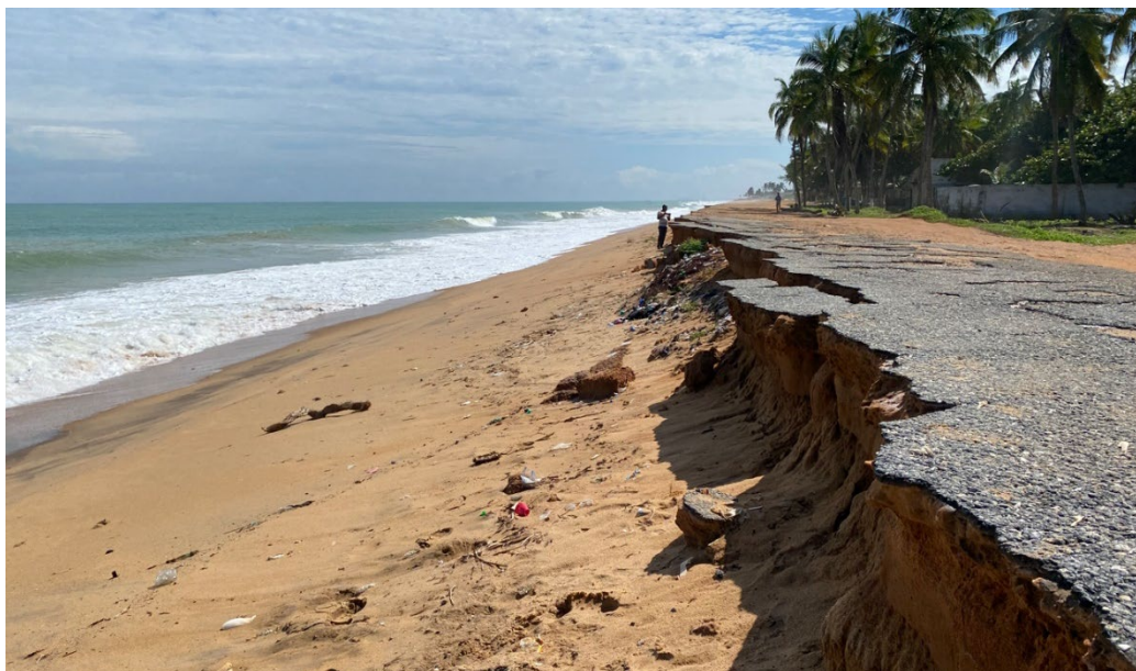
Photo 2. Vestiges de la route allant de Lomé à Aného emportée par l'érosion côtière (juin 2022)
