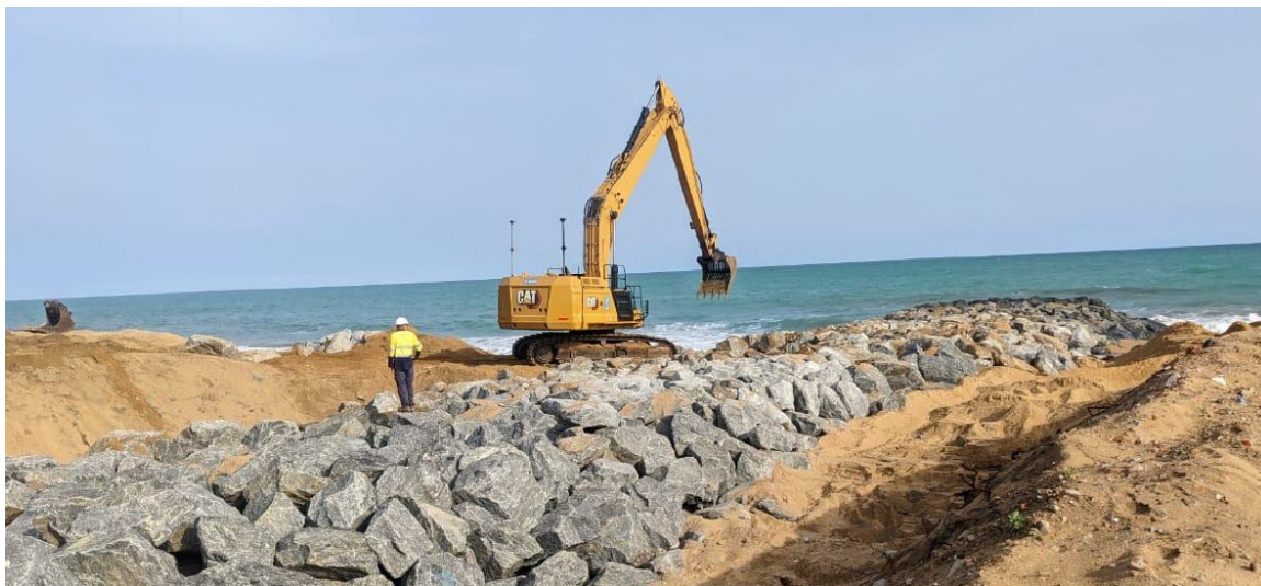
Photo 5. Construction d'épis au Togo (mars 2023)
