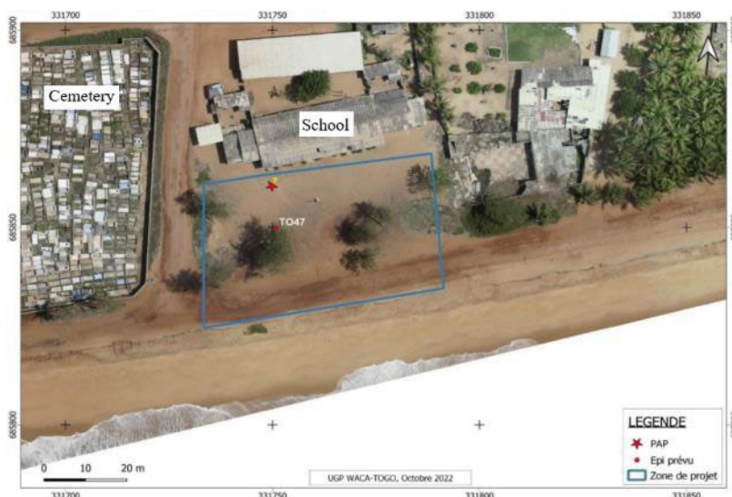
Figure 12 – Une photo aérienne montre l'emplacement de l'épi TO47 par rapport à l'école 208
