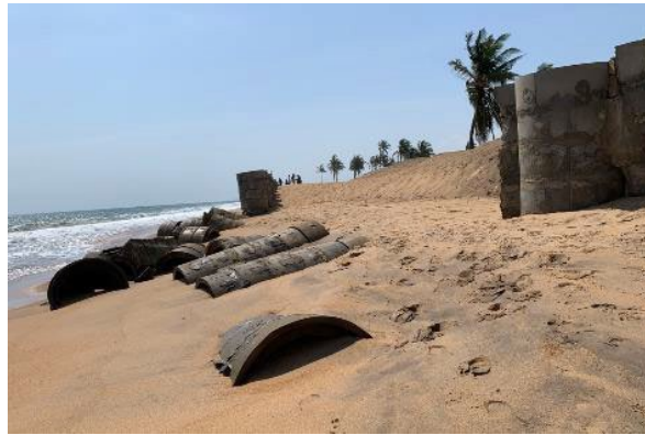
Photos 10 et 11 – buses renversées et cassées à Dévikinmé, le 2022 mai (à gauche) et à Tango, le 2022 novembre (à droite)
