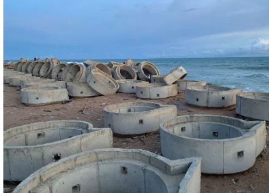
Photo 14 – Des buses (anneaux en béton) entreposées sur la plage d'Adissem (octobre 2021)
