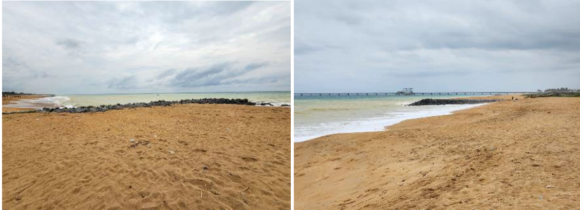
Photos 16 et 17 - Versant est et ouest d'unépis saturé en sable à Goumou Kopé
