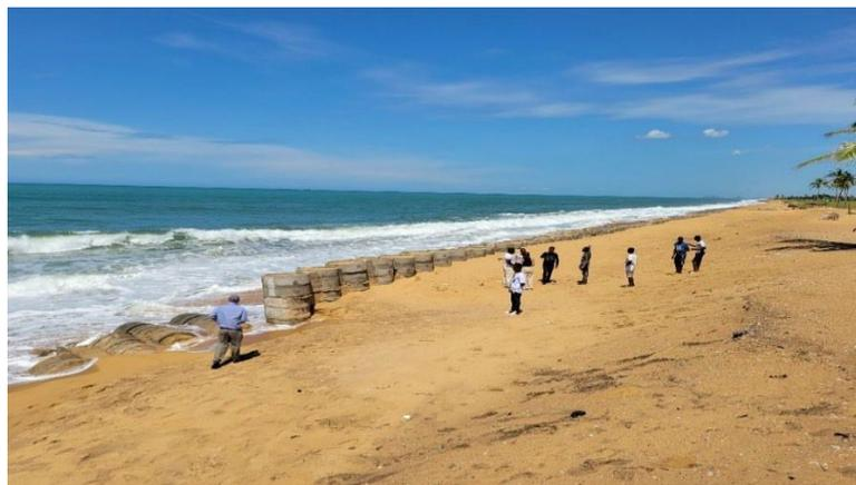
*Photo 3 : Le mur de buses en béton à Tango.*
