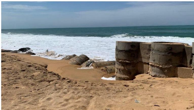
*Photo 1 : Mur de buses en béton, effondré au Togo*
