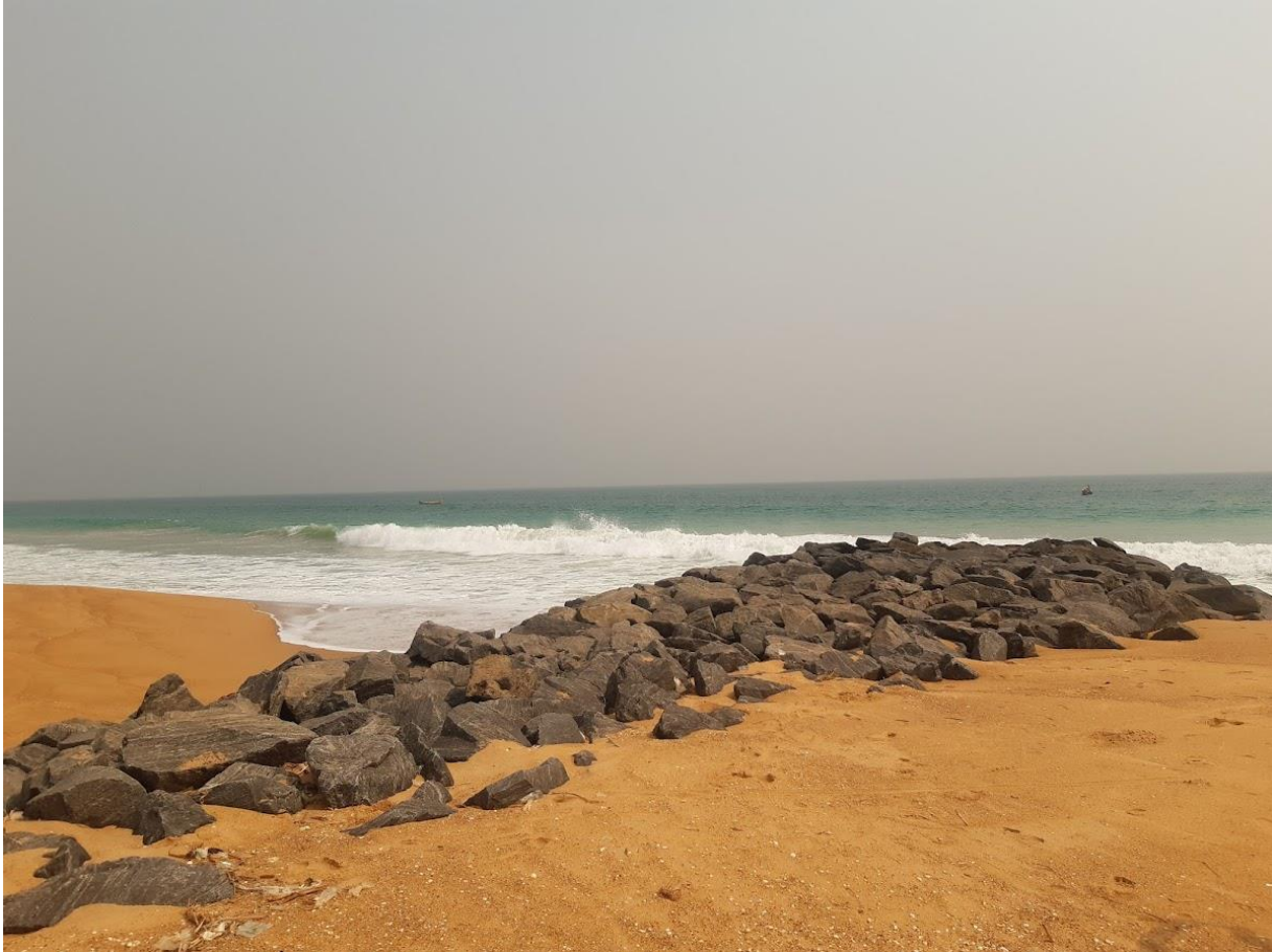
Aného (Est Agbodrafo) : vue d'un des épis de protection existants (construction antérieure à l'intervention du WACA)
