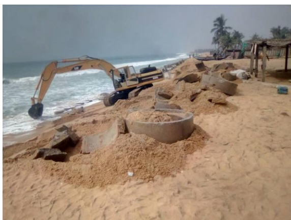
Adissem : pelleteuse en action le 28/01/2022 pour enlever des segments de buses échoués sur l'estran (photos entreprise)
