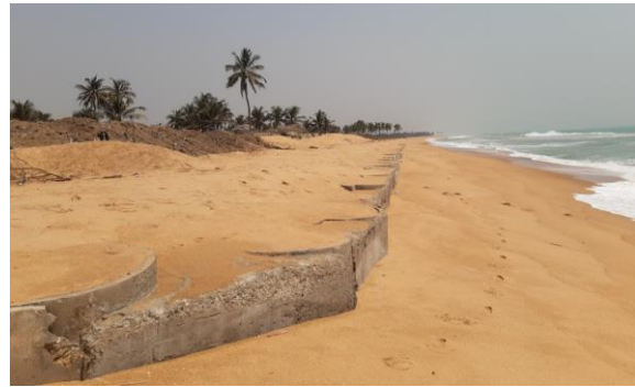
Adissem : vue du prolongement de l'ouvrage vers l'Est depuis le corridor Est
