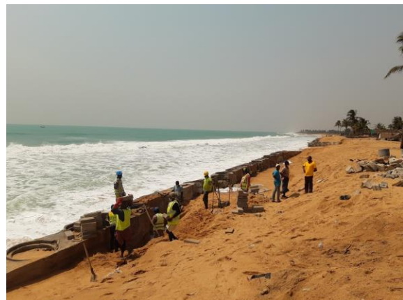
Adissem : partie centrale du mur en cours de réparation / renforcement
