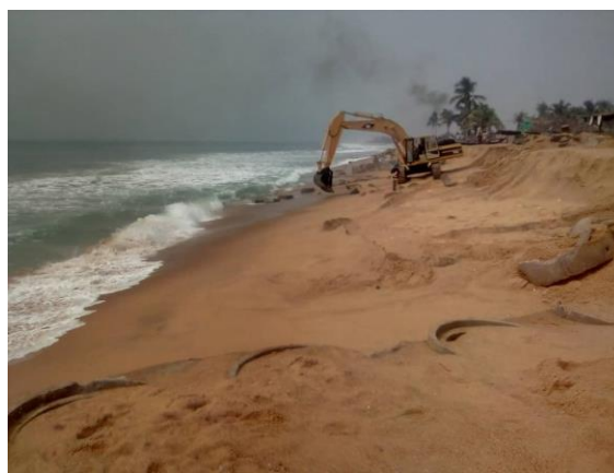
Adissem : pelleteuse en action le 28/01/2022 pour enlever des segments de buses échoués sur l'estran (photos entreprise)
